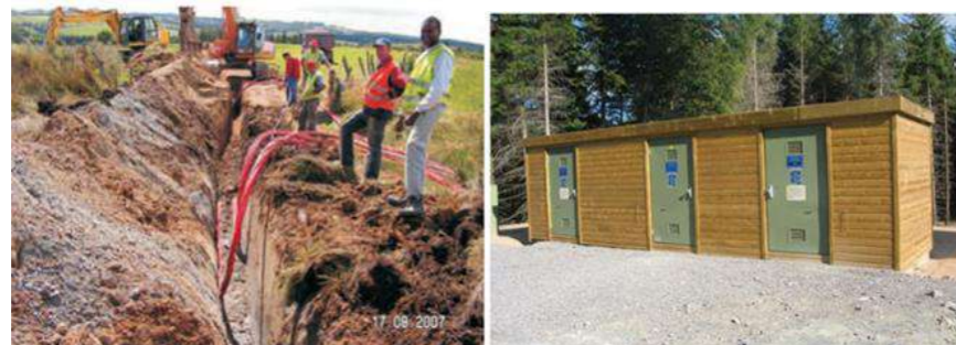
Photographie 6 : Déroulage et pose des câbles (à gauche), exemple de poste de livraison (à droite)
