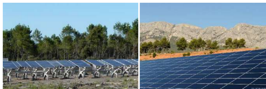
Photographie 1 : Structures solaires (à gauche: les trackers de la centrale de Gabardan (40) qui suivent le soleil ; à droite : structures fixes à Puylobier (13)) - Source : EDF Renouvelables
