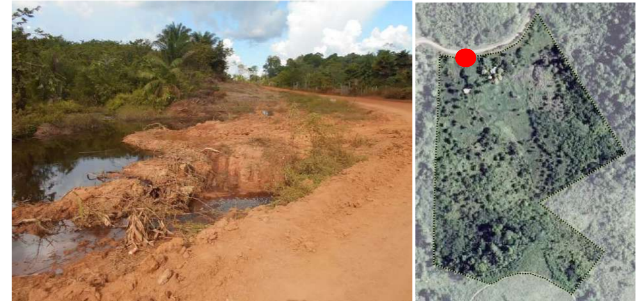
Figure 53 : Défrichage des bords de piste, avec blocage de la crique – © Pelletier Vincent
