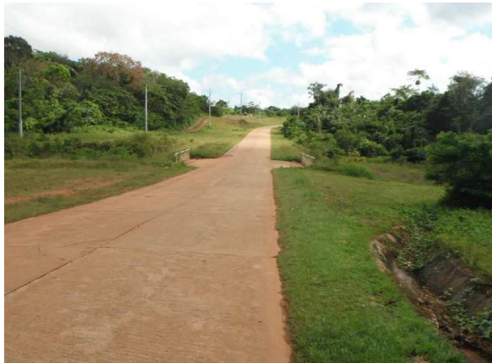
Figure 46 : Route de l'aérodrome juste avant la traversée de la crique Daouda
