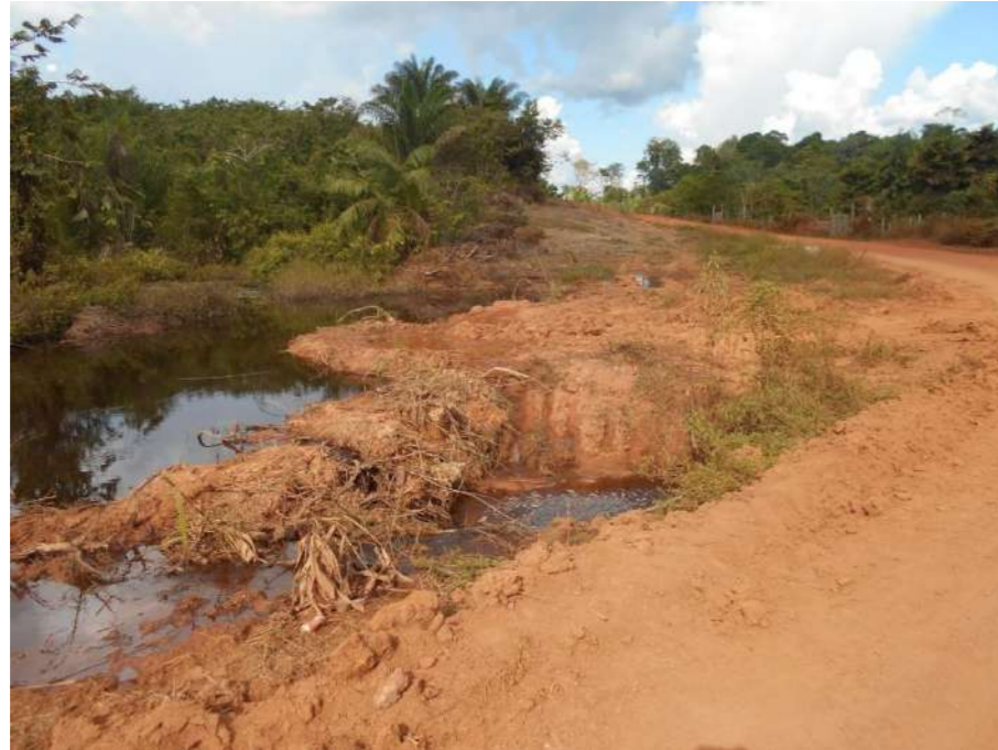
Figure 67 : Défrichement des bords de piste, avec blocage de la crique – © Pelletier Vincent
